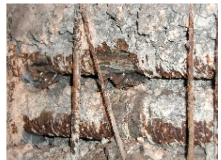
Korrodierte Spannglieder
